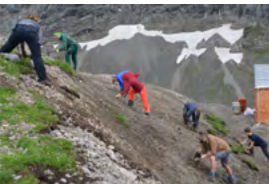
Geländemodellierung um die Hütte von Hand und mit Hilfe eines Schreitbaggers
